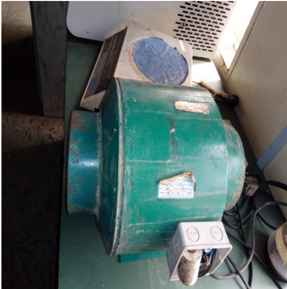
Fume cupboard fan blower
