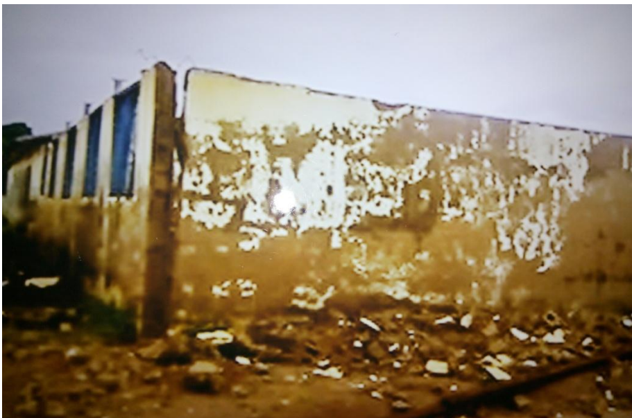
(d) Demolished Hall 11
